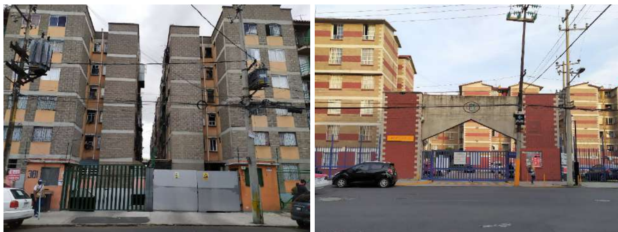
Figura 18. Los conjuntos habitacionales del siglo XXI, Villa Naranjo (izquierda, 07/09/2020) y Santa María (derecha, 26/10/2020) han duplicado la población de la colonia, quedando alejados de los centros de barrio
