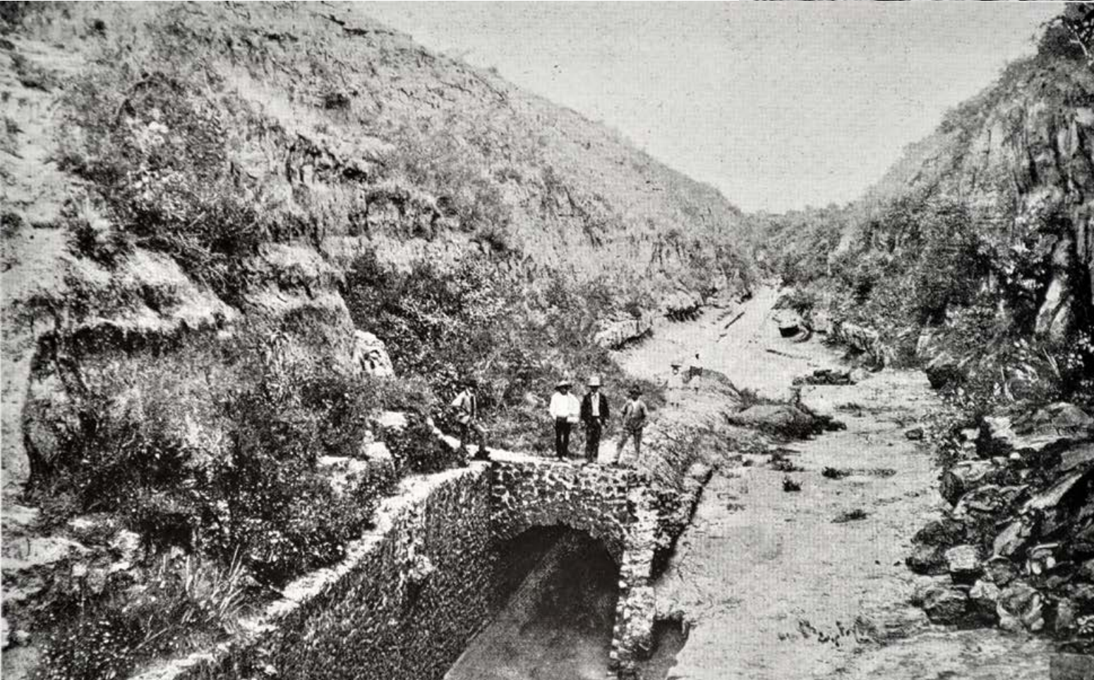
Bóveda Real, último fragmento del túnel Enrico Martínez (Tajo de Nochistongo).
