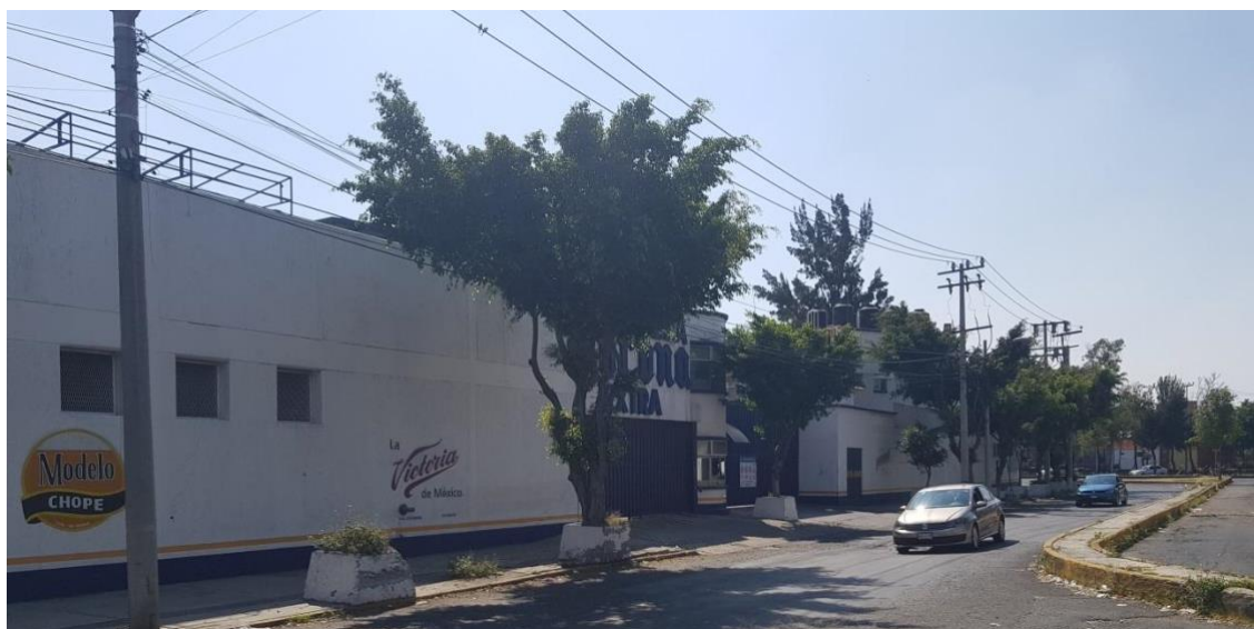
Fotografía 2 Fachada del Centro de Distribución del Grupo Modelo Agencia OCEANÍA, Av. F.F.C.C. Industrial 9, Moctezuma Segunda Sección, Venustiano Carranza, 15530, CDMX
